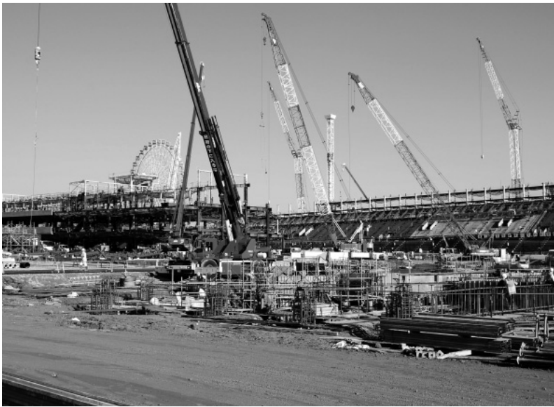
改修工事が進む鈴鹿サーキット
