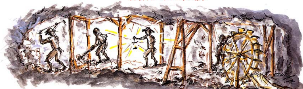
ながらやま 長等山トンネル工事の様子
