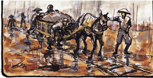
馬車による土砂の運搬
