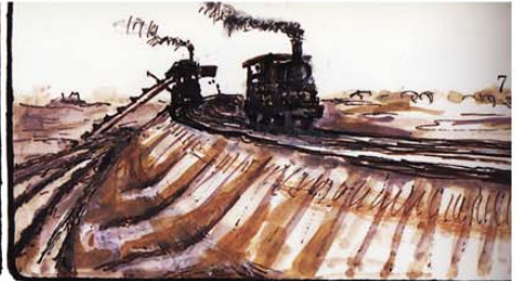
くっさく機と機関車による土堤づくり
