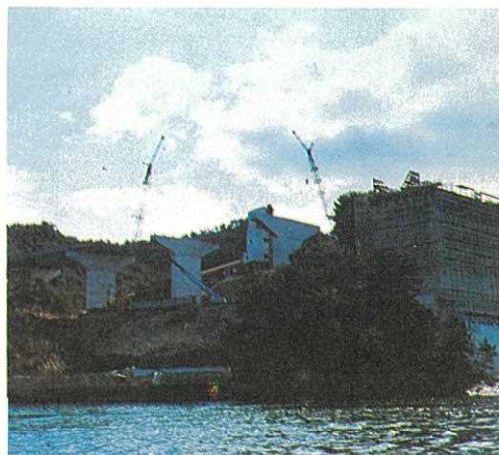
大三島橋（伯方島側から）
