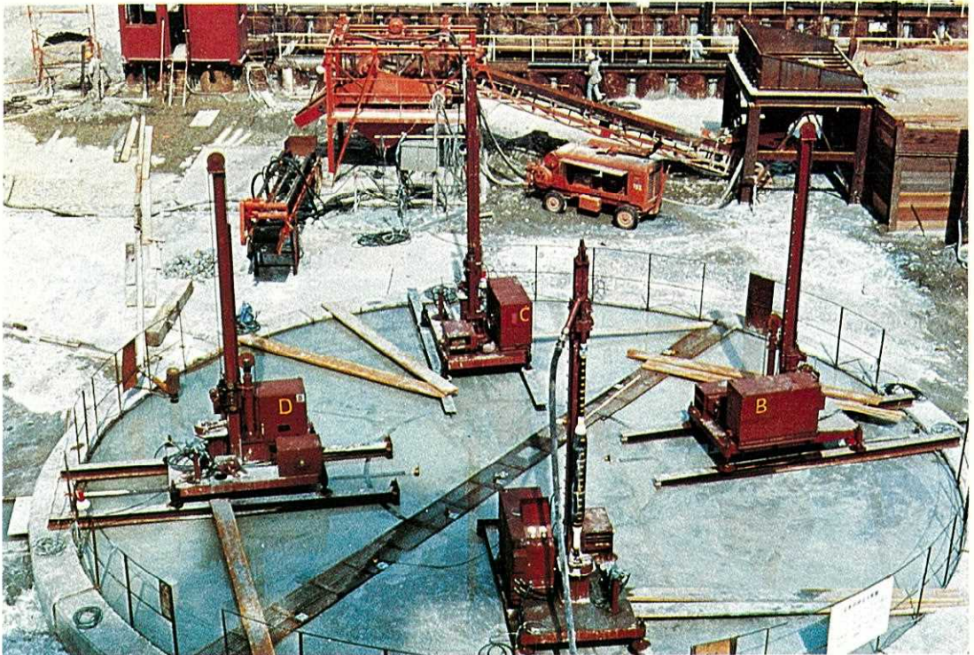
プレバッドコンクリート大規模注入実験 (48年4月)
