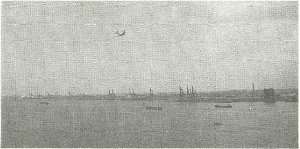
大井コンテナ埠頭の全景 右側に東京港トンネルの換気塔が見える。
