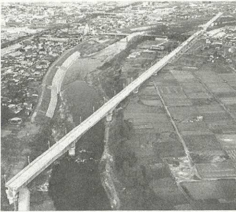
第2阿武隈川橋りょう（前方） 第3阿武隈川橋りょう（後方）
