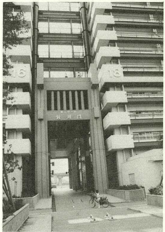
避難ゲート「鐘淵門」 7個の放水銃がつけられている
