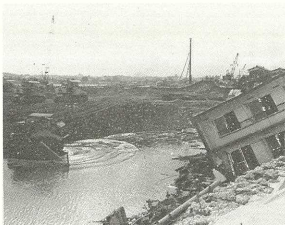
昭和49年、多摩川決壊のあとの復旧作業
