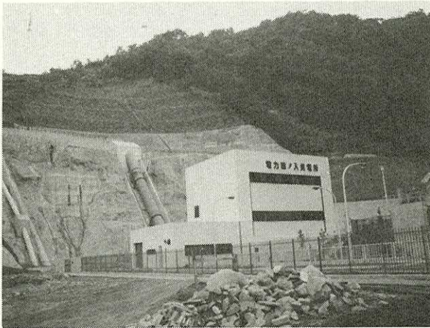
ダムの下流部にある田ノ入発電所
