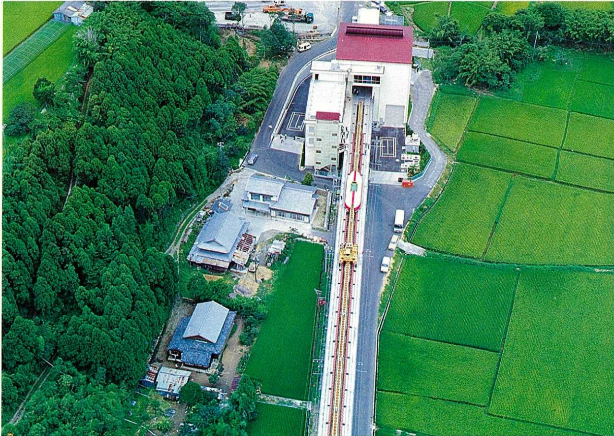
宮崎県日向市美々津のリニアモーターカー実験センター
