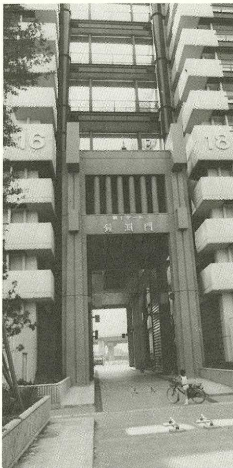
東京墨田区白髪東地区の防災拠点ビル
