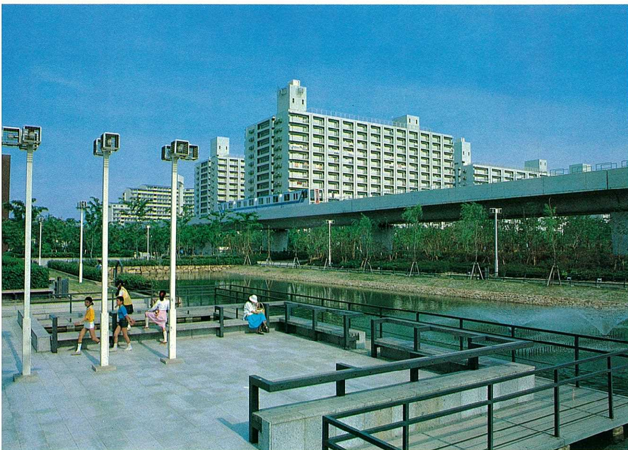
▲南港ポートタウンの中を走る新交通システム「ニュートラム」。3月16日開通。
