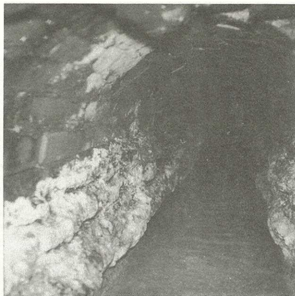
◀ 中華街南門下で現在も使われている煉瓦管 (横浜市下水道局提供)
