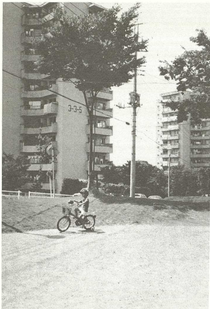
多摩ニュータウン永山団地付近
