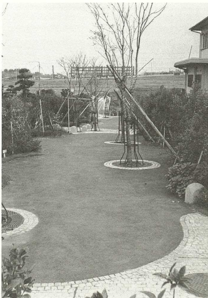
▲コミュニティ道路 ちょっとした広場のようにつくられていて、車も進入できるが、スピードは出せない。
