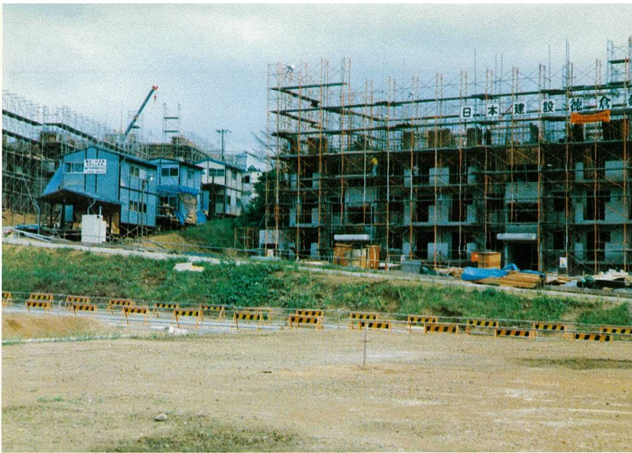
▲港北ニュータウンの第二地区では、来年八月入居予定の住宅の建設がすすんでいる。
