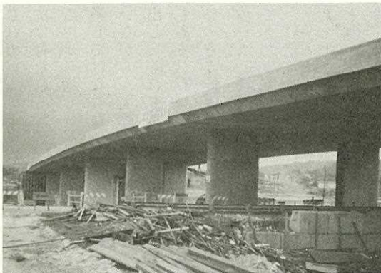
マレーシアの高架道路建設現場
