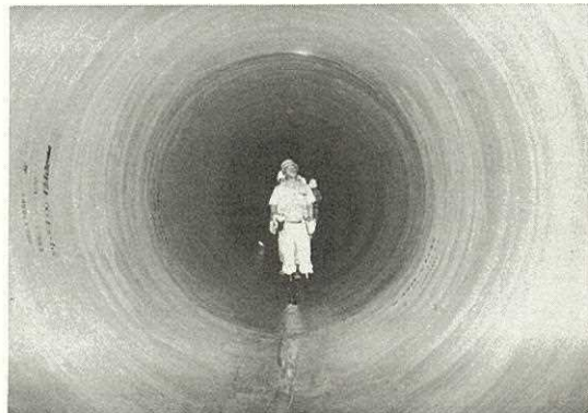
完成した下水道内部
