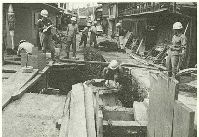
下水道工事風景（高山）
