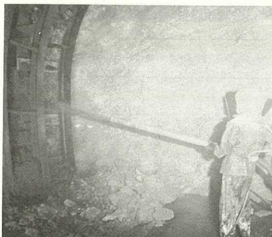
吹付コンクリート
