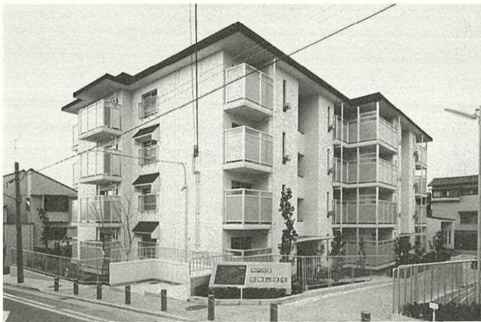
神戸市営、歌敷山住宅
