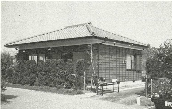
宮崎県営 天井丸団地（木造集会所）
