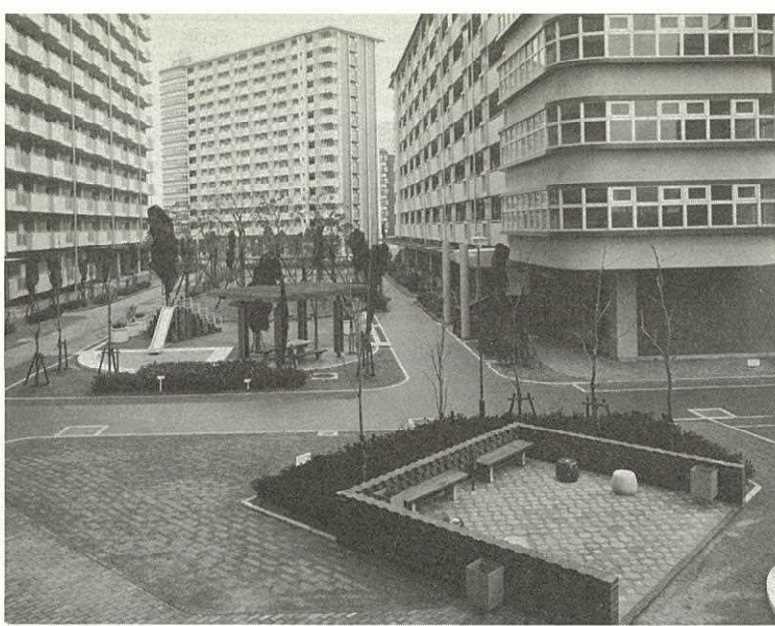
神戸市営 港島住宅
