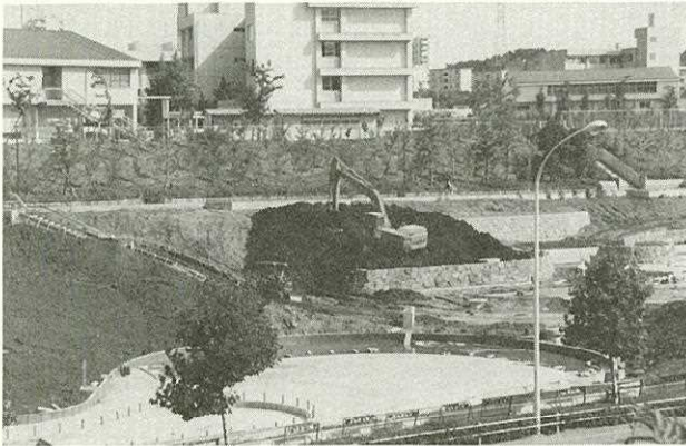
盛土工 (多摩NT地区)
