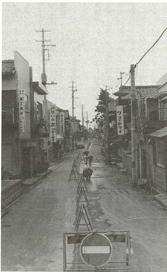
安田町・降雪に備えて町道消雪パイプ伏設工事
