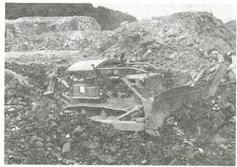
(トレンチ造成 天竜川河川敷)
