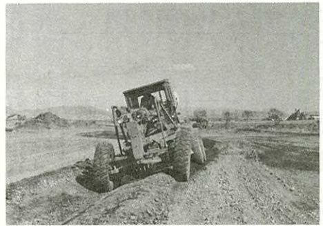
(原石山掘削、日中ダム)
