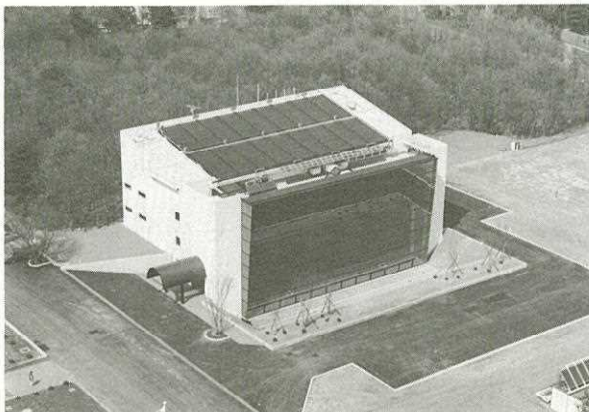
大林組技術研究所本館
