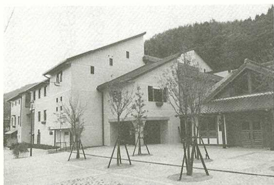
町制30周年で建てたタウンホール
