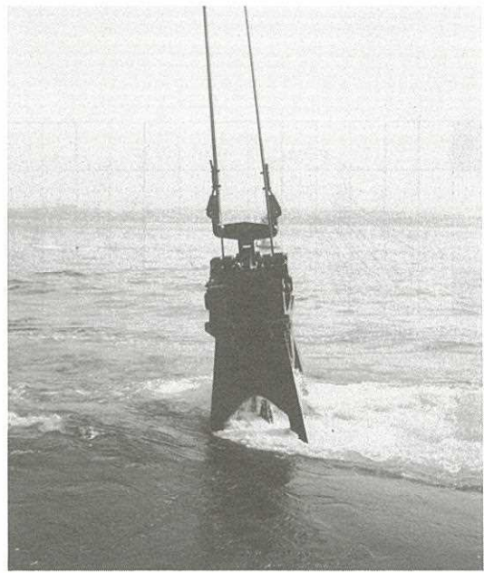
明石海峡・海底掘削実験
