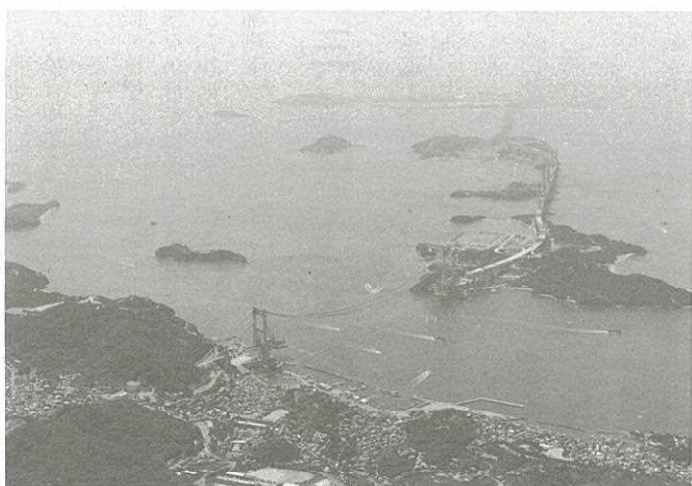
児島・坂出ルート海峡部の全景（鷺羽山上空より）
