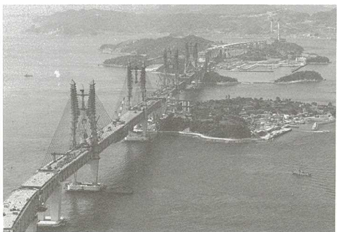
櫃石島橋(向う側)、岩黒島橋(手前)
