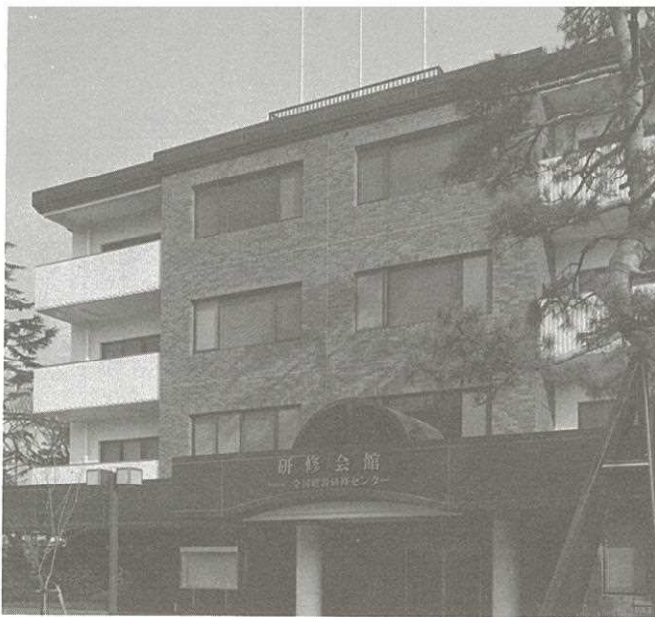
建設研修第二会館
