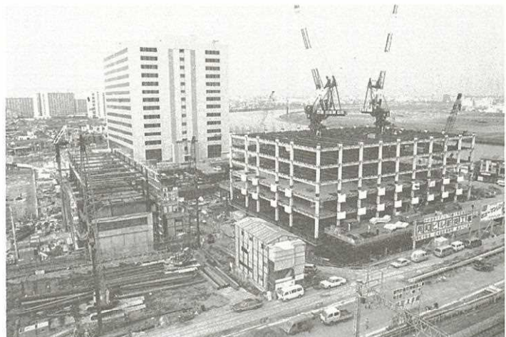
建設進むテクノピア第1特定地区 (中央は完成した東芝ビル、右手に多摩川を望む)
