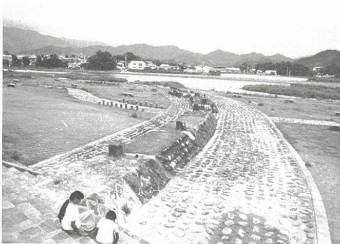
土佐藩家老 野中兼山ゆかりの歴史的史跡、山田堰の遺構を保存して高水敷を整備 高知県土佐山田町物部川
