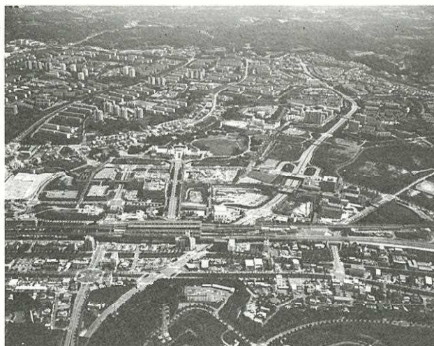
多摩センター地区航空写真
