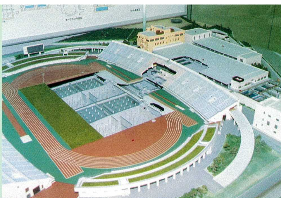
◀万博記念公園競技場 (地下に10万㎡の浄水池をおさめている)
