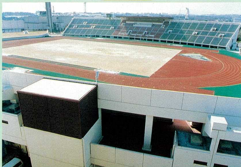
▶村野階層浄水場の模型 (30万トンの加重に耐えるよう基礎コンクリート厚は4 mにおよぶ)
