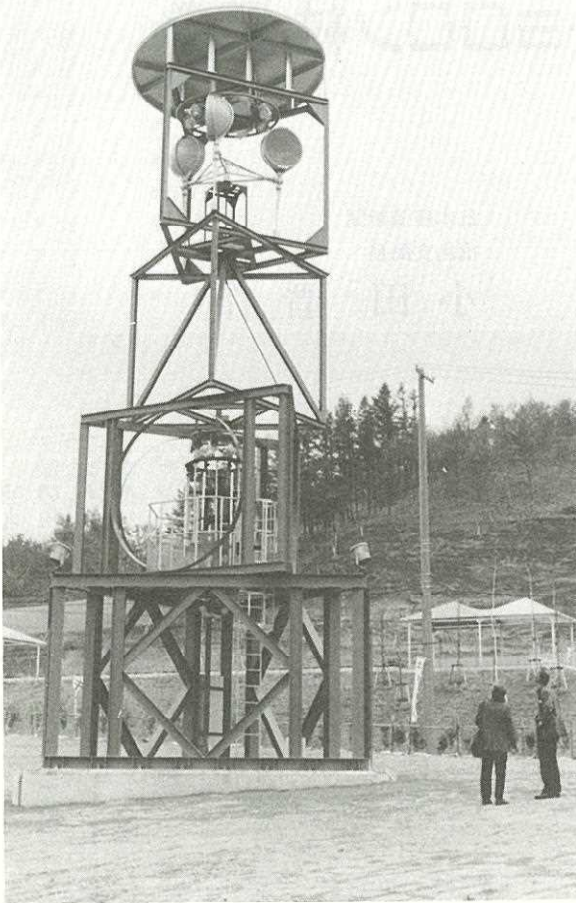
風力で鐘を鳴らすユニークなシンボルタワー
