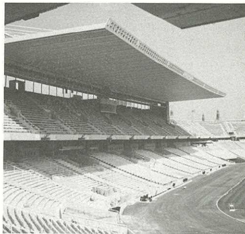
建設が進むオリンピック競技場
