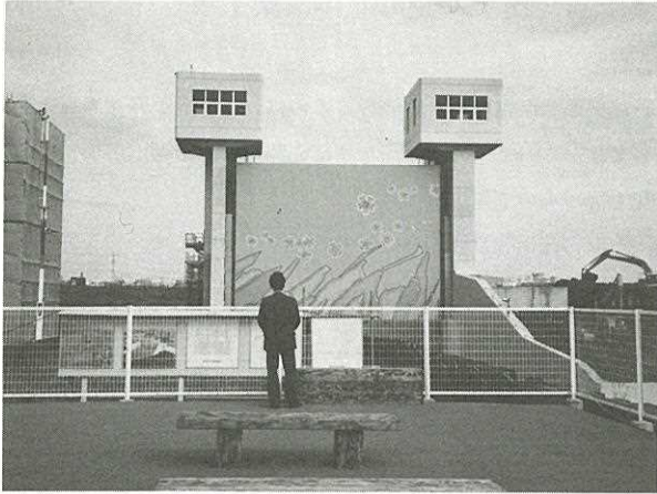
見学スペースも整備された（昭和水門改築工事）
