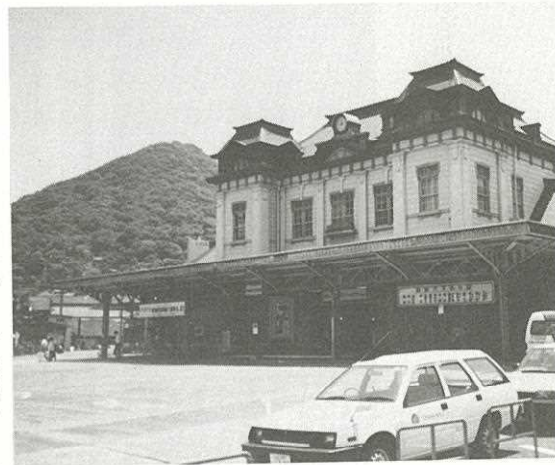
国の重要文化財に指定されたJR門司港駅舎
