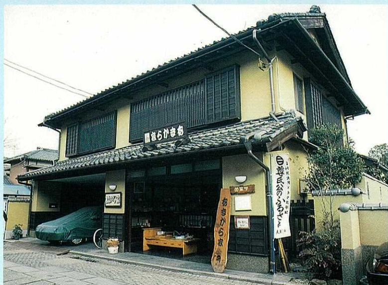
まちなみ修景建物 （普通の民家を修景し、石畳み道に マッチした景観が作りだされた部分）
