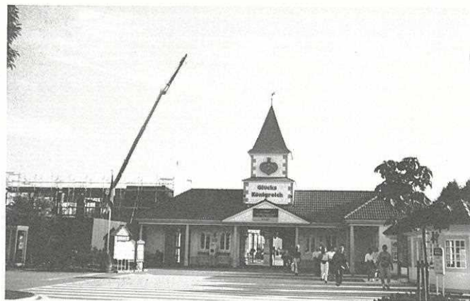
正面入口脇で、第2期工事が進む
