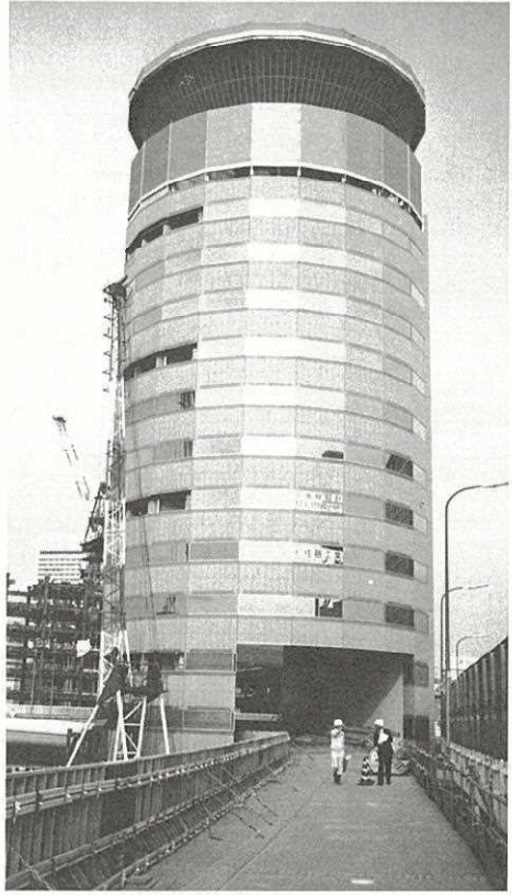
現況高速道路との、すり付け部分近くから見る 道路一体建物
