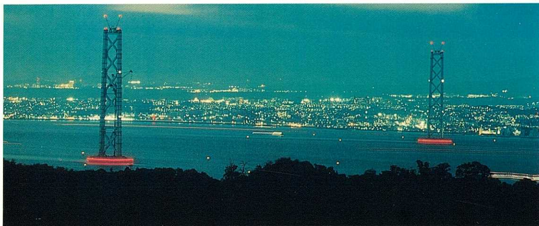
▲淡路側より神戸を望む
