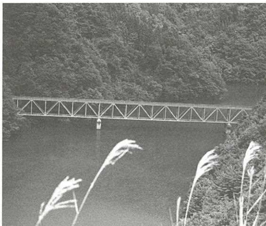
JR只見線の第三只見川橋梁
