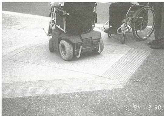
写真7 縁石カット。視覚障害者に配慮して、歩道より白っぽい仕上げで、境には杖で探索しやすいように線状に凹凸がつけられている。
