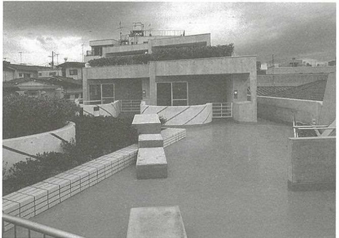
屋上テラスに面した高齢者単身用住宅
