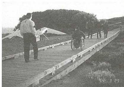
写真9 サンフランシスコのフォートファンストーン。木製(耐久性を倍増するための薬品処理加工済み)のアクセシブルなデッキ
