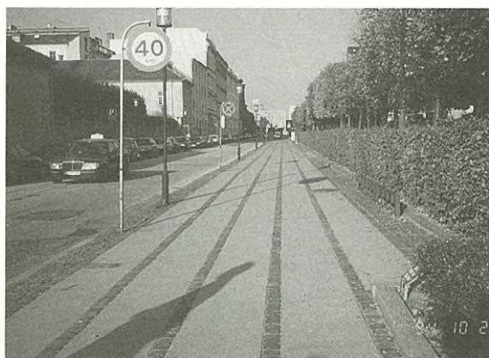
写真5 コペンハーゲンの歩道。敷石が歩車道間及び適当な間隔で一直線に敷かれている。
