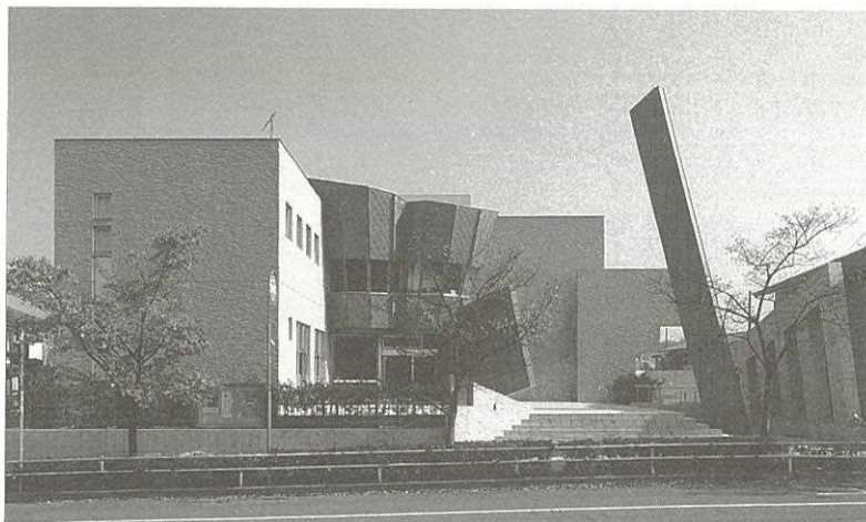
八王子保健所南大沢保健相談所・幹線道路沿いの正面とアプローチ
