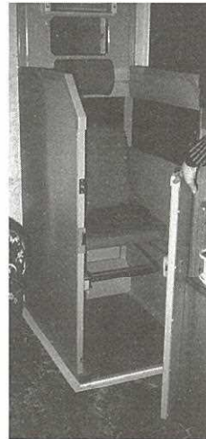
写真4 1階居間・2階寝室間の床を貫通させて昇降するリフターのかご。かごが他階にある時には床面は使用できる省スペース型。
