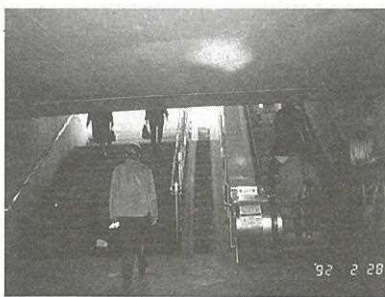
写真10 ストックホルム市内駅構内の階段に設置されている乳母車用スロープ
