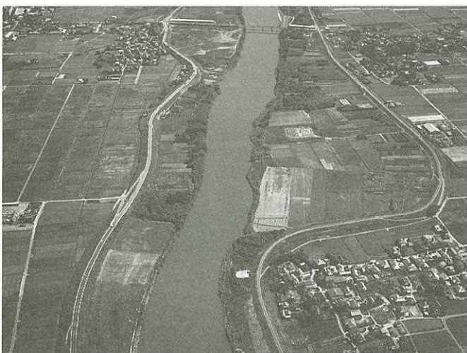
写真-2 緑川の桑鶴塘(建設省熊本工事事務所提供)
