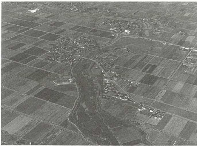
写真-3 浜戸川のくつわ塘と越流堤(建設省熊本工事事務所提供)
