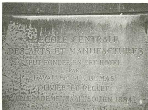
▲創立当初、中央工業大学が置かれた建物の正門にはめ込まれた銘板 (1977.8.29撮影)
