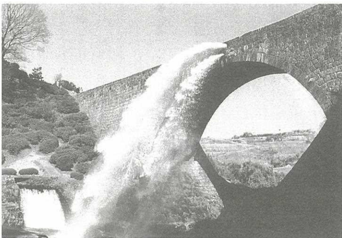
通潤橋 (矢部町)
