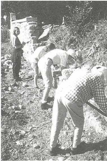
写真7 国際ボランティア イギリス・ナショナル・トラストの施設・ストウ・ランドスケープ・ガーデンズで石垣の修復作業にたずさわる日英のボランティア。石垣の修復は、二五〇〜三〇〇年ぶり。
