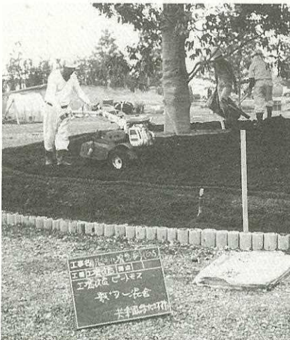
写真① 敷均し 地ごしらえ
