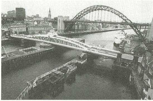
写真4 ニューカースル・アポン・ティン ウオーター・フロント沿いは、中層の建物で抑えられ、現代的な高層ビルは離れて建ち、しかも少ない。それゆえ橋の景観的シンボル性とスケール感が保持されている。アーチのティン橋は1928年竣工、旋回橋は1876年につくられ、なんと今もなお現役に稼働している。
