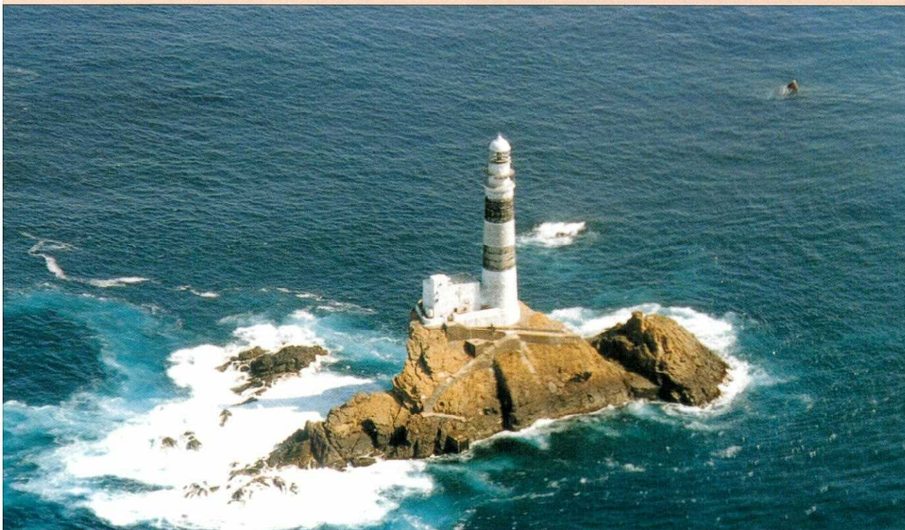
水の子島灯台 1904(明治37)年竣工。(海上保安庁所蔵)
