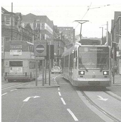
シェフィールド（イギリス）に建設されたLRT
