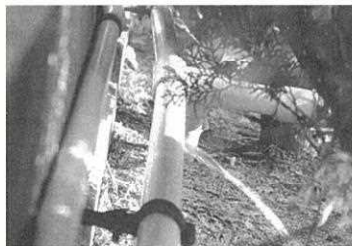
ベランダの外観と散水の様子 塩化ビニールパイプの穴から雨水が出る仕組み。ベランダの植物は、落葉が少ないものが選ばれた。
