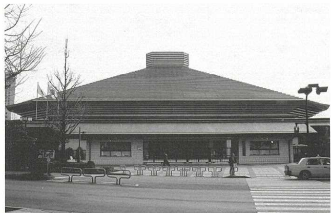
日本初の雨水利用施設 「両国国技館」 約8,400 m の屋根に降った雨水を地下の1,000 m のタンクにため、トイレの洗浄や空調の冷却補給水として使用している。
