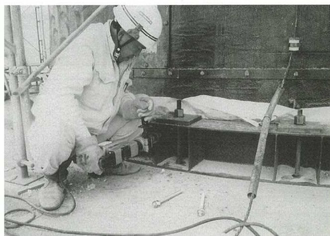
灯台と附属舎のジョイント部
