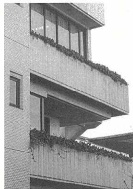
ベランダの外観と散水の様子 塩化ビニールパイプの穴から雨水が出る仕組み。ベランダの植物は、落葉が少ないものが選ばれた。
