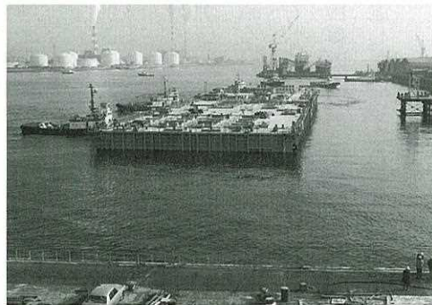
写真1 巨大なコンクリート函体の曳航 「海上に築く下水処理場」
