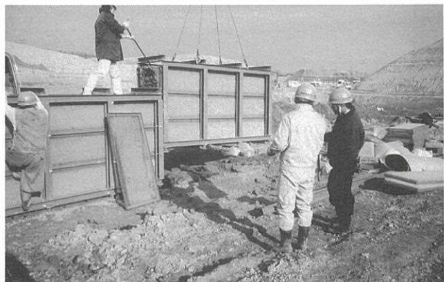
●堤体ブロックの搬出
