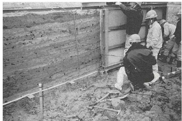
●堤体ブロックの補強
