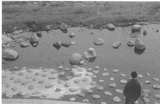
三重県長野川における自然に配慮した改修の結果、河床の一部がコンクリート化され、頭大の石が嵌め込まれている。また、流心部（写真の上側）には不自然な間隔で一抱え以上の石が均等に配置されている。
