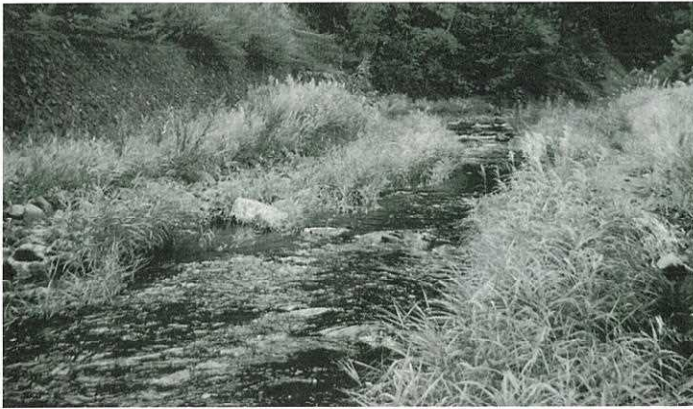
現地に自生するツルヨシが植栽された瀬川の護岸
