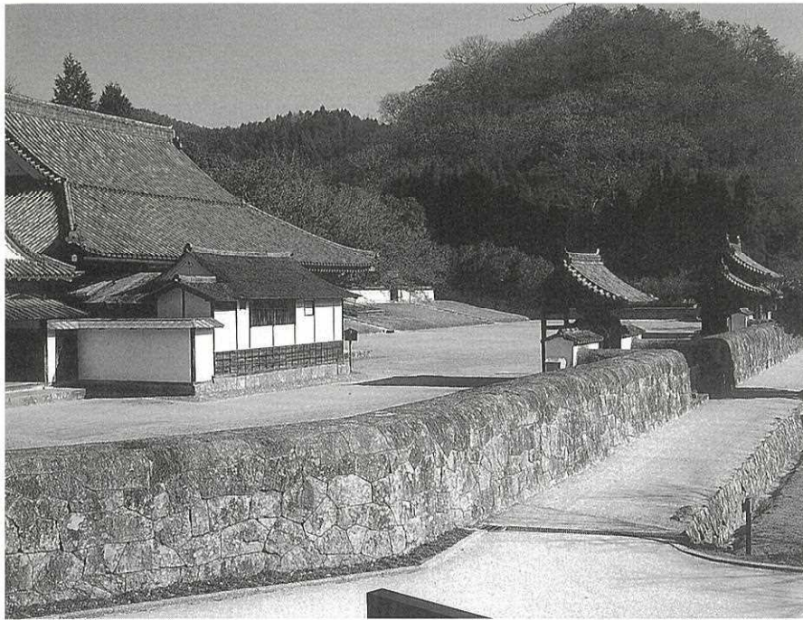
閑谷学校の石垣 元禄防波堤と形状が似るだけでなく、石材にも同質のものが用いられている。
