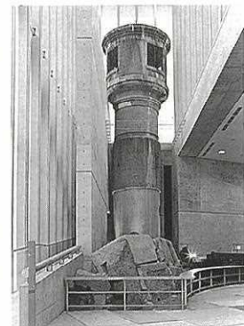
写真③ 取水塔と中樋
