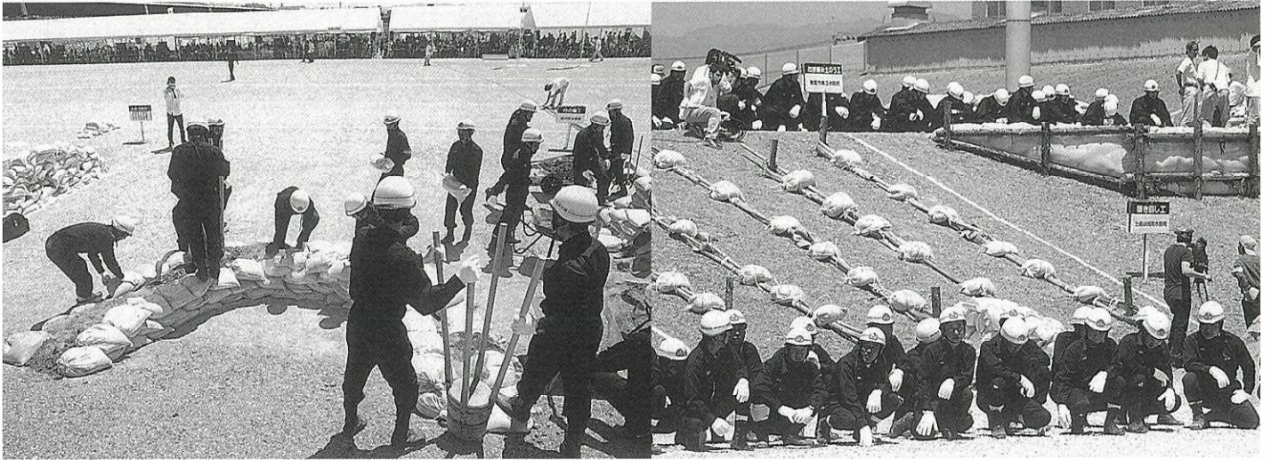
昔ながらの水防工法が今に受け継がれている(左から月の輪工、繋ぎ縫い工、五徳縫い工。物部川・仁淀川水防演習より)
