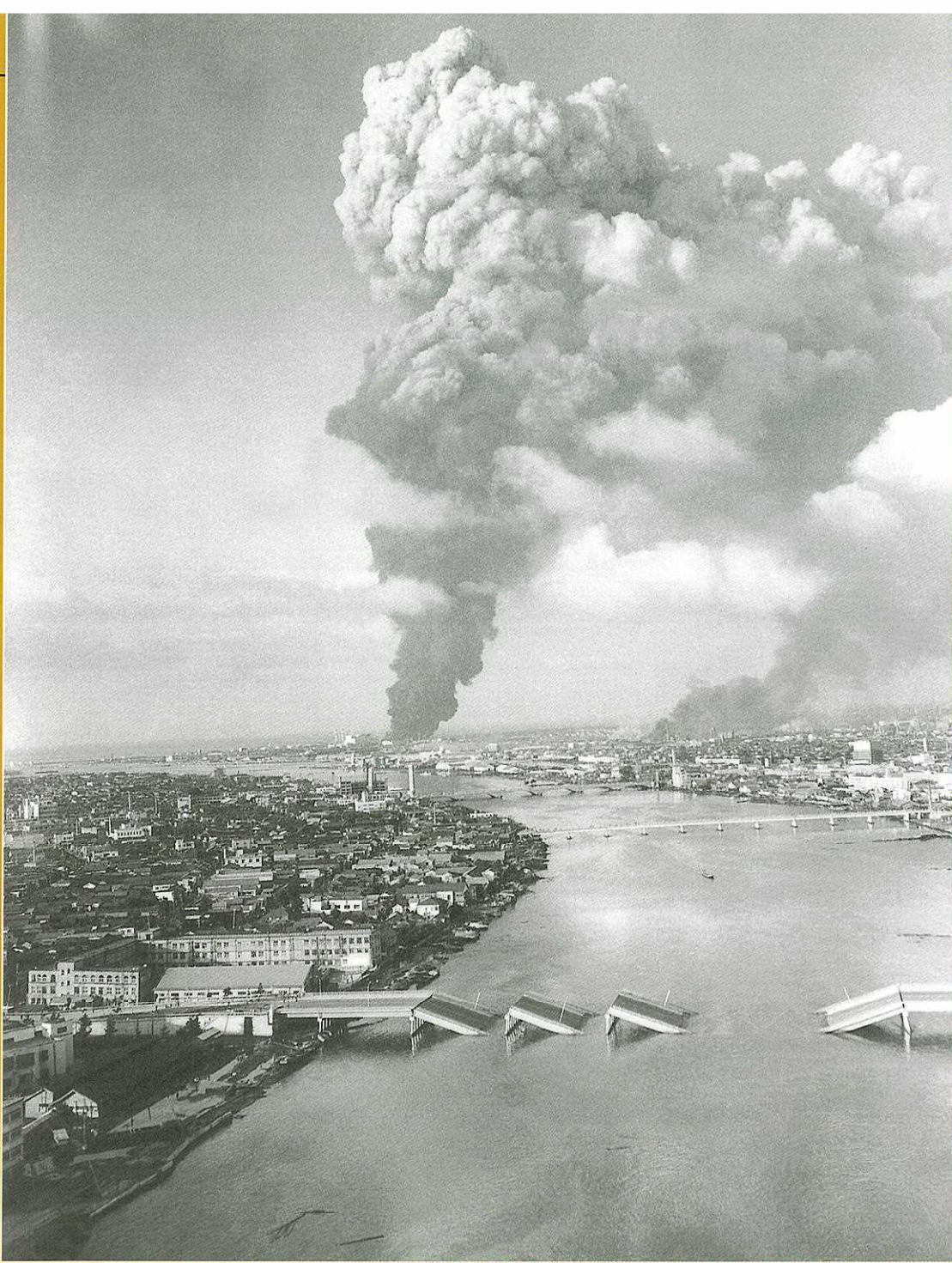
昭和39年6月16日、新潟地震が発生、新潟市内では石油タンクが爆発して15日間燃え続け、信濃川にかかる昭和大桥が落橋した ©共同通信社
