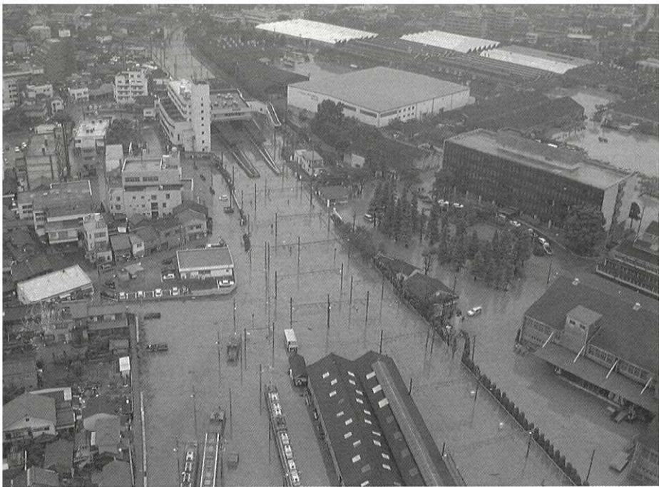
東海水害では都市計画のあり方も大きく問われた(名鉄須ヶ口駅周辺)
