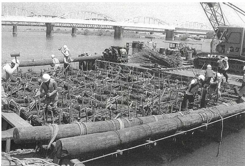
阿賀野川での粗梁沈床の施工
