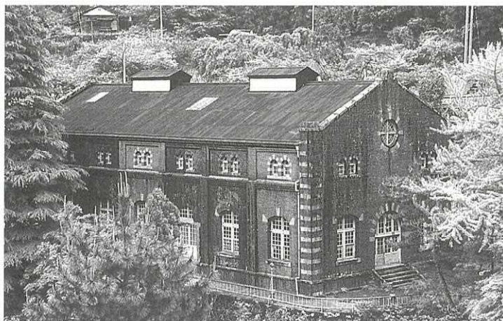
住友端出場水力発電所（現在は変電所）
