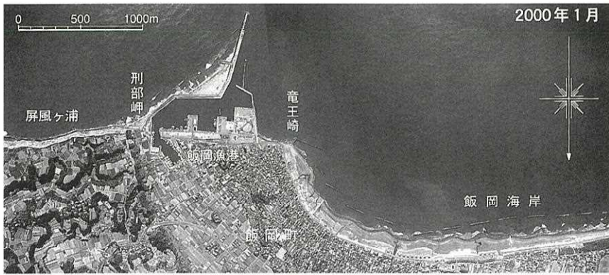
写真1 飯岡漁港の空中写真（2000年1月撮影）
