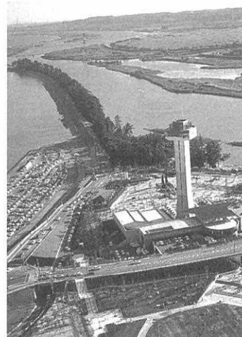
木曾三川分流工
