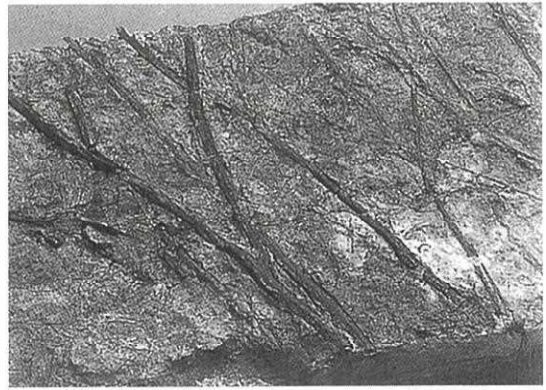
狭山池の敷葉工法
