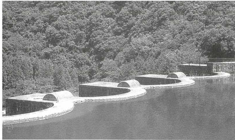
上流部の連続するアーチ形部分 いっぱいに水が溜まっている
