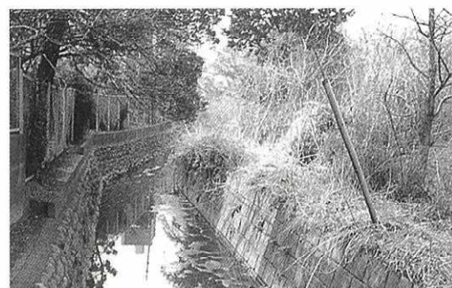
整備前の水路は近寄り難い場所だった (パンフレット『向島用水親水路』より)
