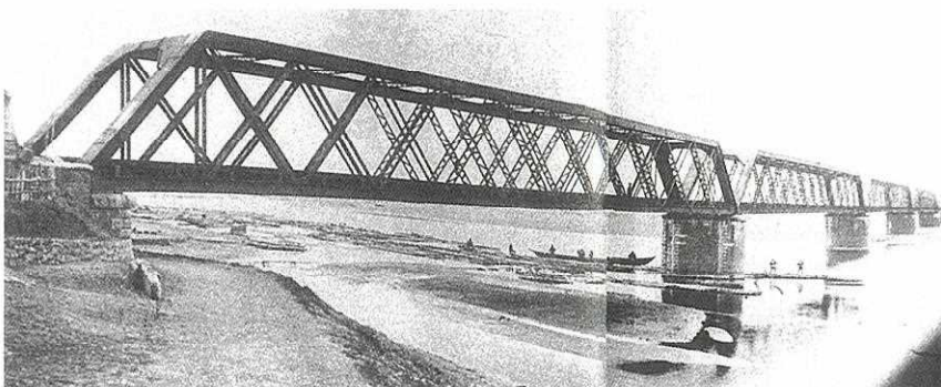
木曾川鉄橋 (明治18年10月中山道幹線として着工、明治20年4月東海道線として完成。571メートル)
