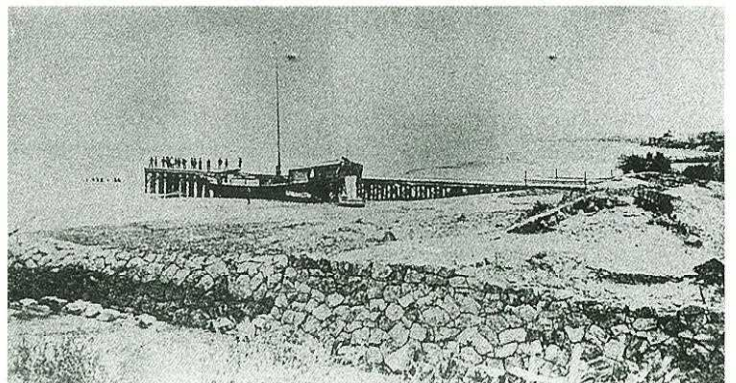
中山道幹線建設資材陸揚げの武豊木製棧橋
