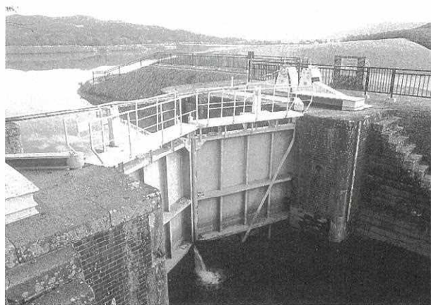
石井閘門の近辺から旧北上川を見る
