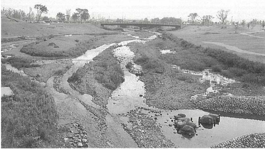
自然環境等に配慮した可変性のある社会資本整備が求められている (写真：山形市・村山高瀬川の多自然型川づくり)
