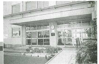
▲太子堂中学校昇降口 時計の下には地域防災協力校の掲示と、昨年受賞した防災まちづくり大賞総理大臣賞の表彰パネルが飾られている
