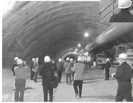
第二東名富士川トンネル
