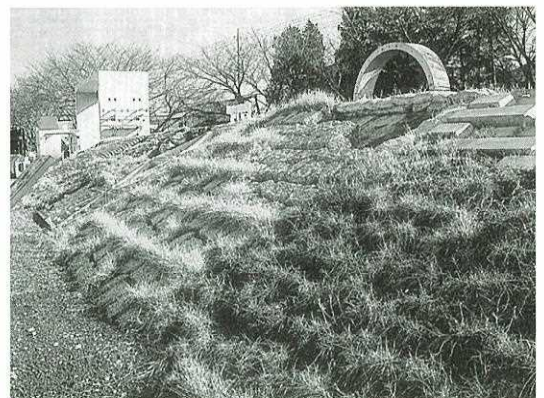
環境に配慮した護岸（新技術コーナー・屋外展示場）
